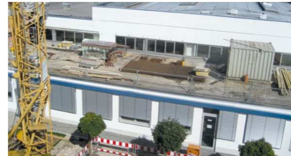
Während der Umbauphase der Sozialräume
