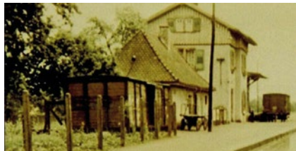
Im alten Bahnhofsgebäude wurden Mitte der 70er-Jahre die ersten Serienteile gefertigt
