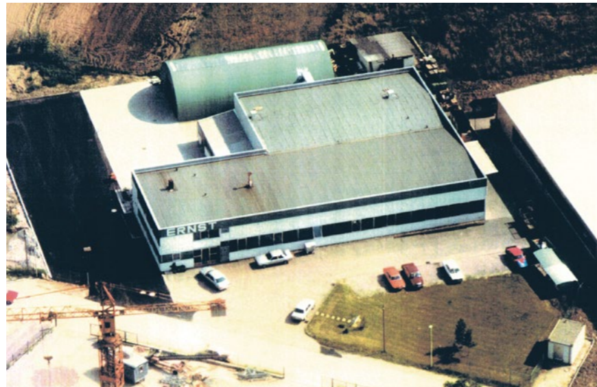
Luftaufnahme des Unternehmens Mitte der 80er Jahre
